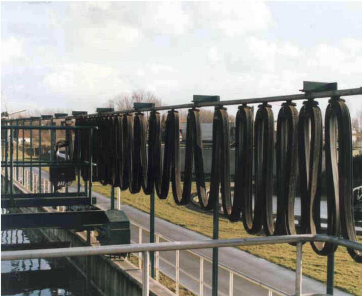
AKAPP laplaablitega festoonsüsteem veepuhastusjaamas
